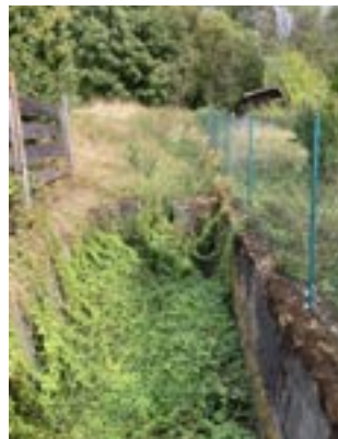
Der Heitzhöferbach ist verlandet und zugewachsen. Da fließt das Wasser nicht gut ab.
